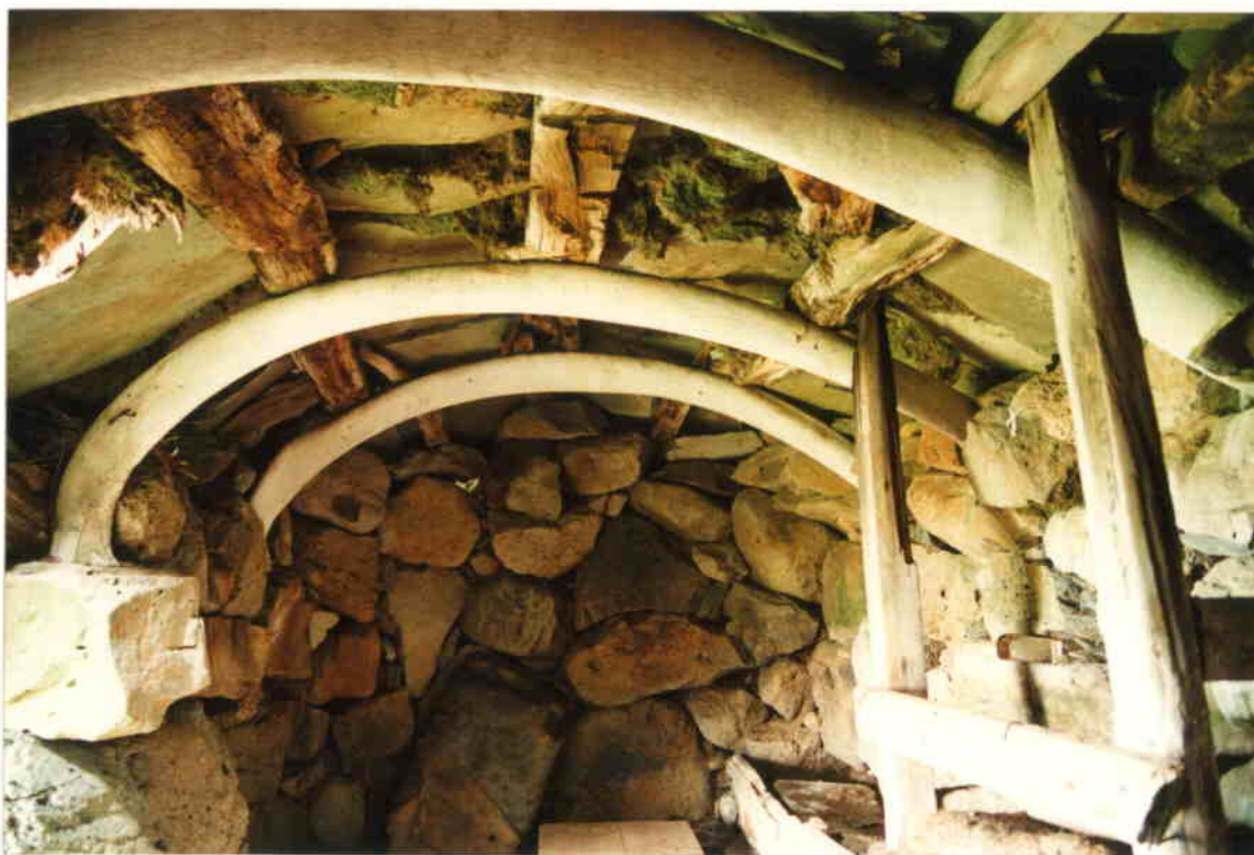
Horft upp í þakið inn í fjárhúsinu. Hvalbeinin hvíla á veggjumum. Jatan er til hægri.
